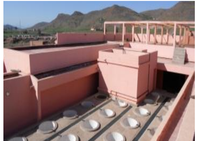
الشكل 11 : إعادة بناء مديعة تقليدية
